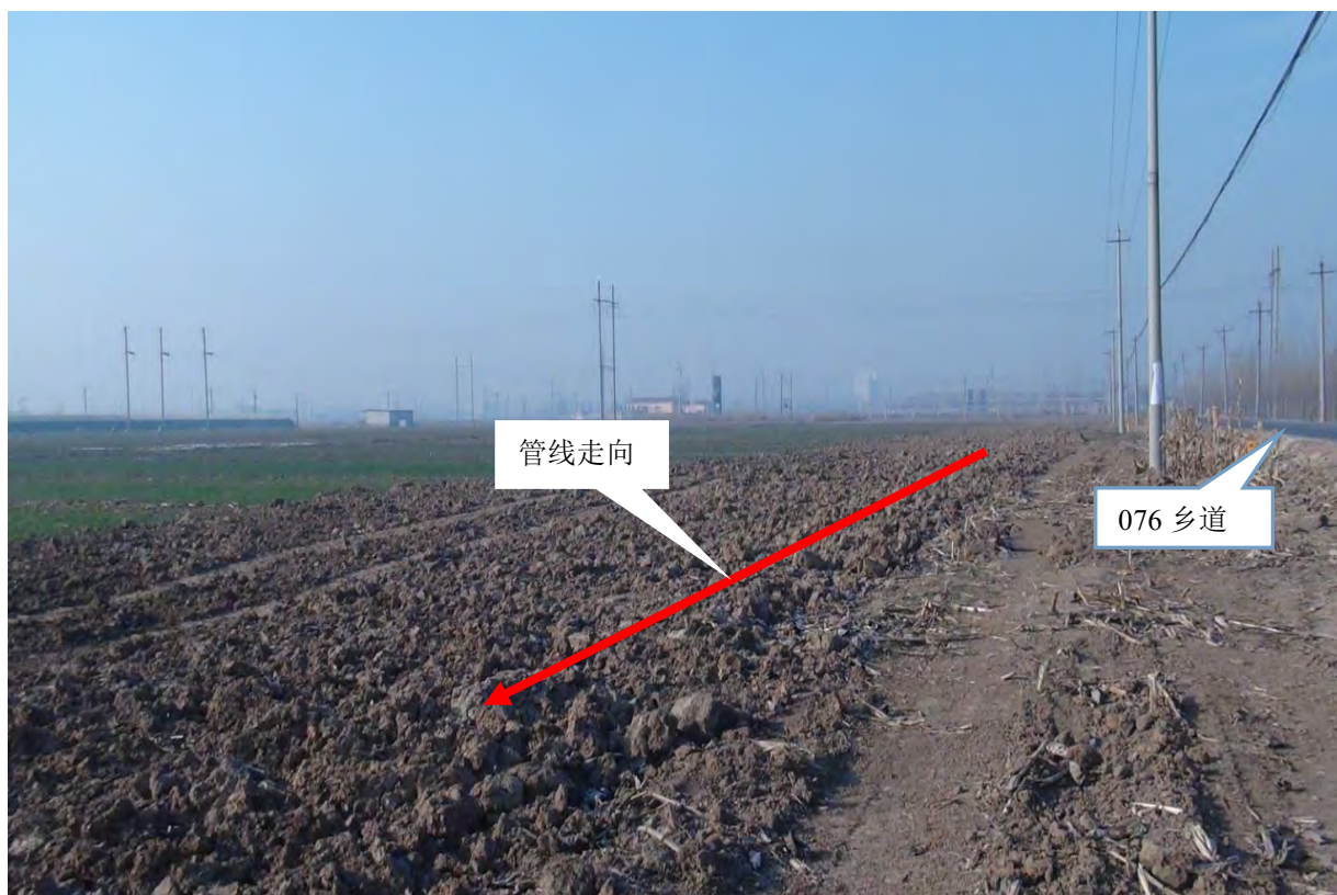
站外热力管线敷设占地情况
