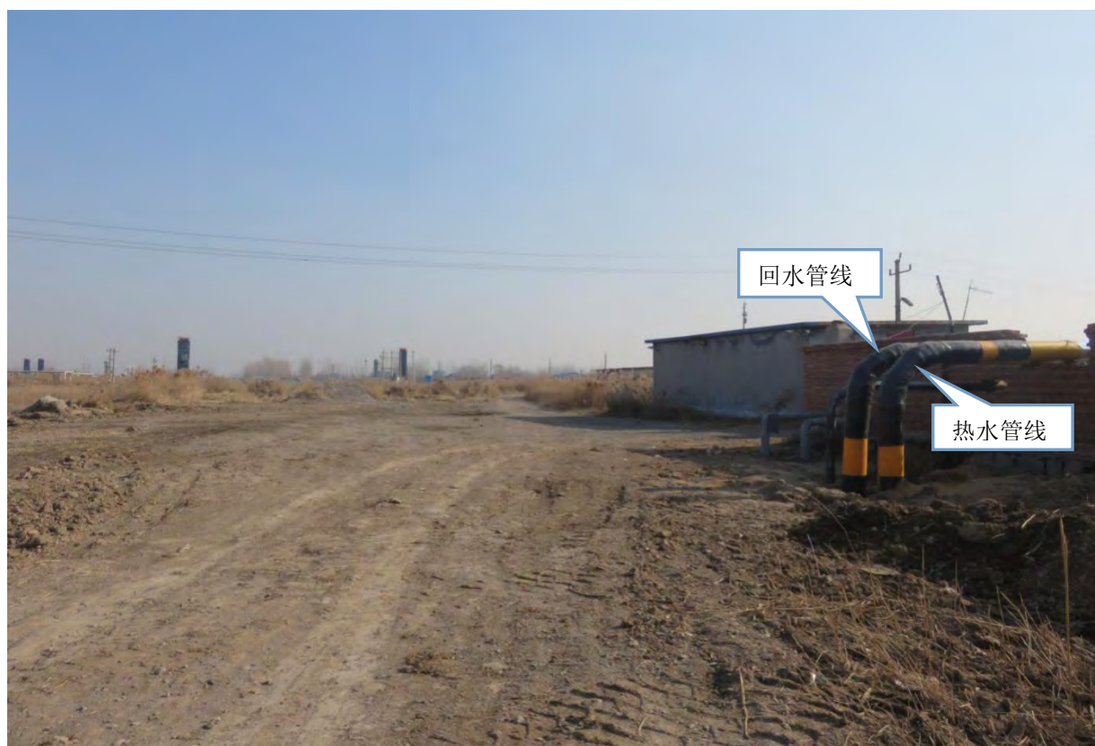
2 号接转站外该项目管线
