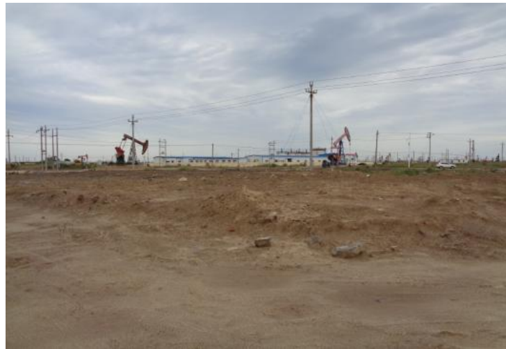
泥浆池固化覆土后照片
