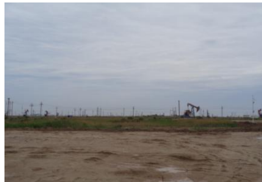
井场路边生态恢复情况
