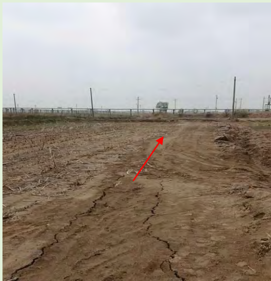
图 5-1 项目管线敷设处现状图
