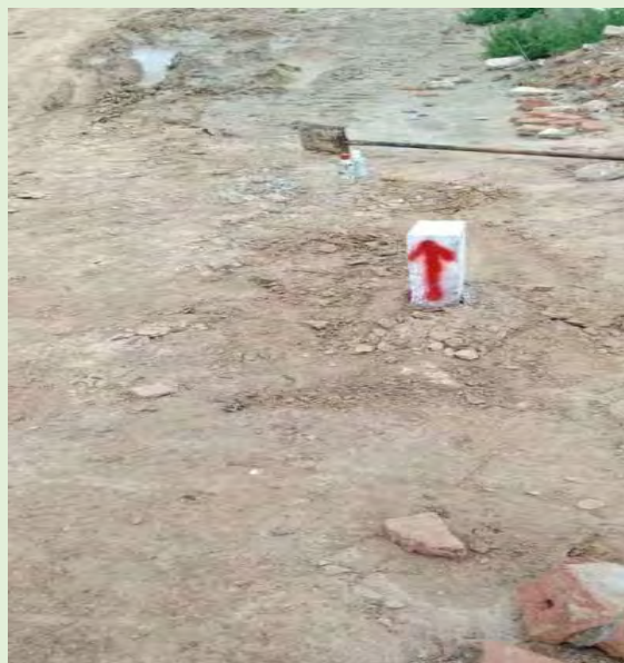
图 3-4 集油管线标志桩照片
