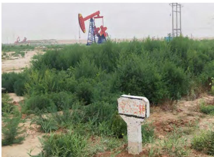
图 3-3 集油管线标志桩照片
